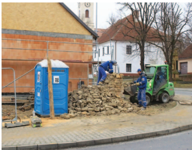
Odstranění staré hliněné (kotovicové) zdi na návsi
