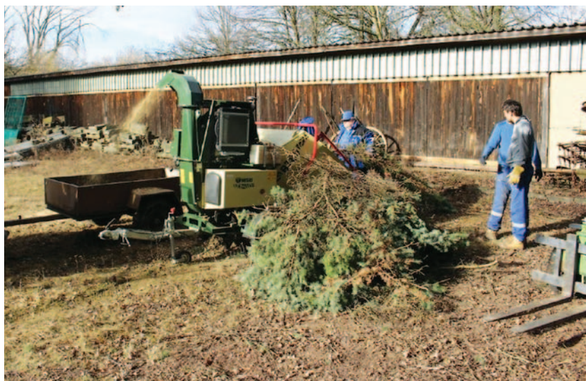
Úklid prostoru bývalé střešnice a štěpkování zeleně
