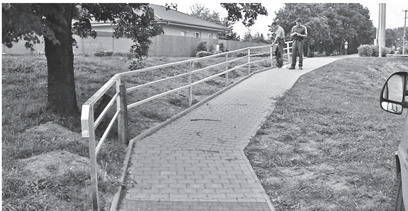
Z bezpečnostních důvodů bylo v měsíci září nainstalováno zábradlí u nového chodníku v parku u Smetanového. Výrobu a montáž provedl Radek Švábenský a Miroslav Tichý.
